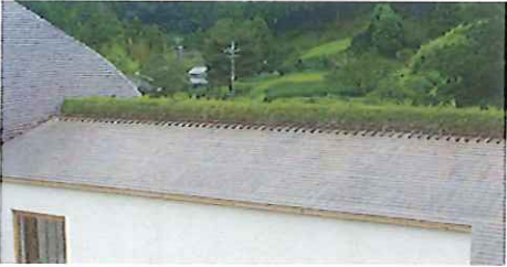
屋根の頂上に土を盛り、土が崩れないように草を植えた棟。草を植える作業には、学園の子どもたち、設計者である藤森氏の知人らによる縄文建築団（※）が参加しました。
