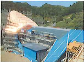
銅板瓦葺き工事 (1)
