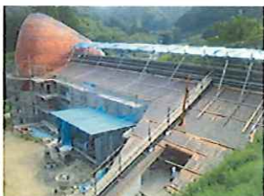
屋根上芝棟工事
