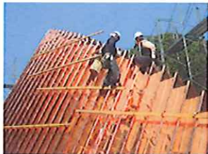
銅板瓦葺き工事 (2)
